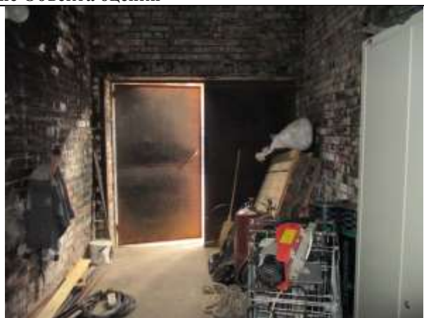
Фото 8. Внутреннее состояние Объекта оценки
