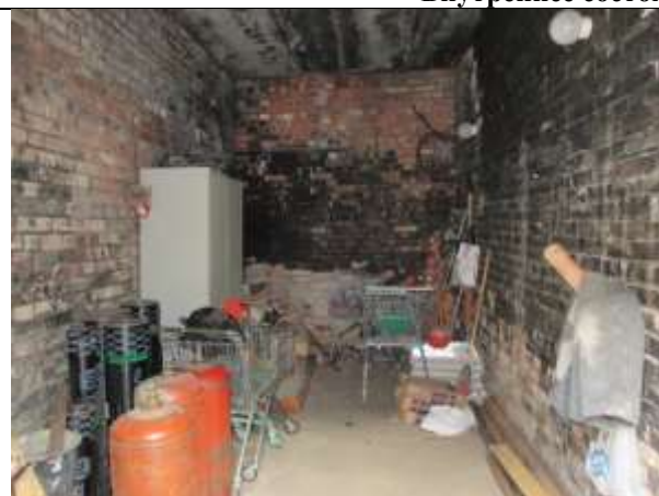
Фото 7. Внутреннее состояние Объекта оценки
